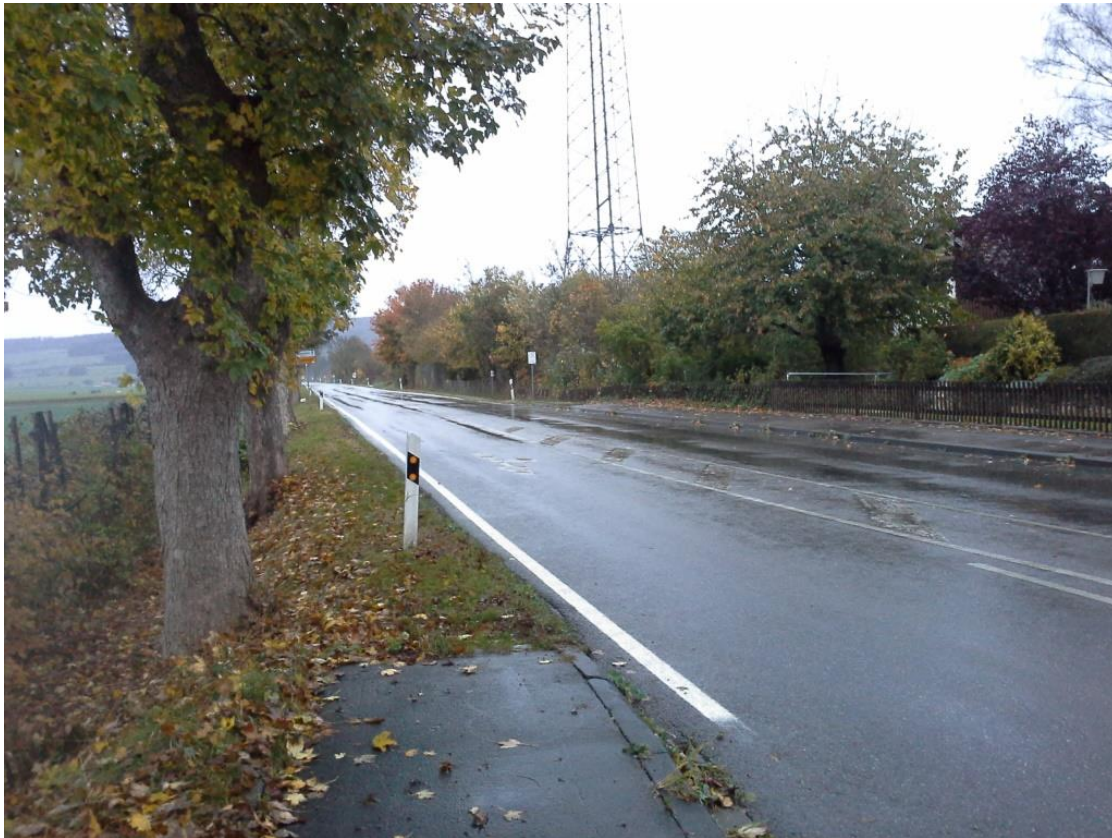
Netzlücken, fehlende Querung, Gammertinger Straße
