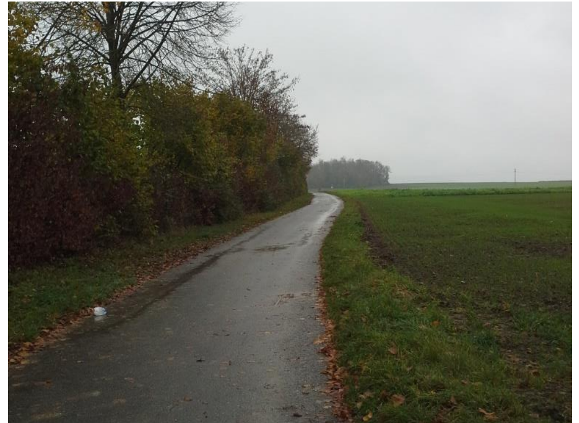
Straßenbegleitender Radweg, B 312
