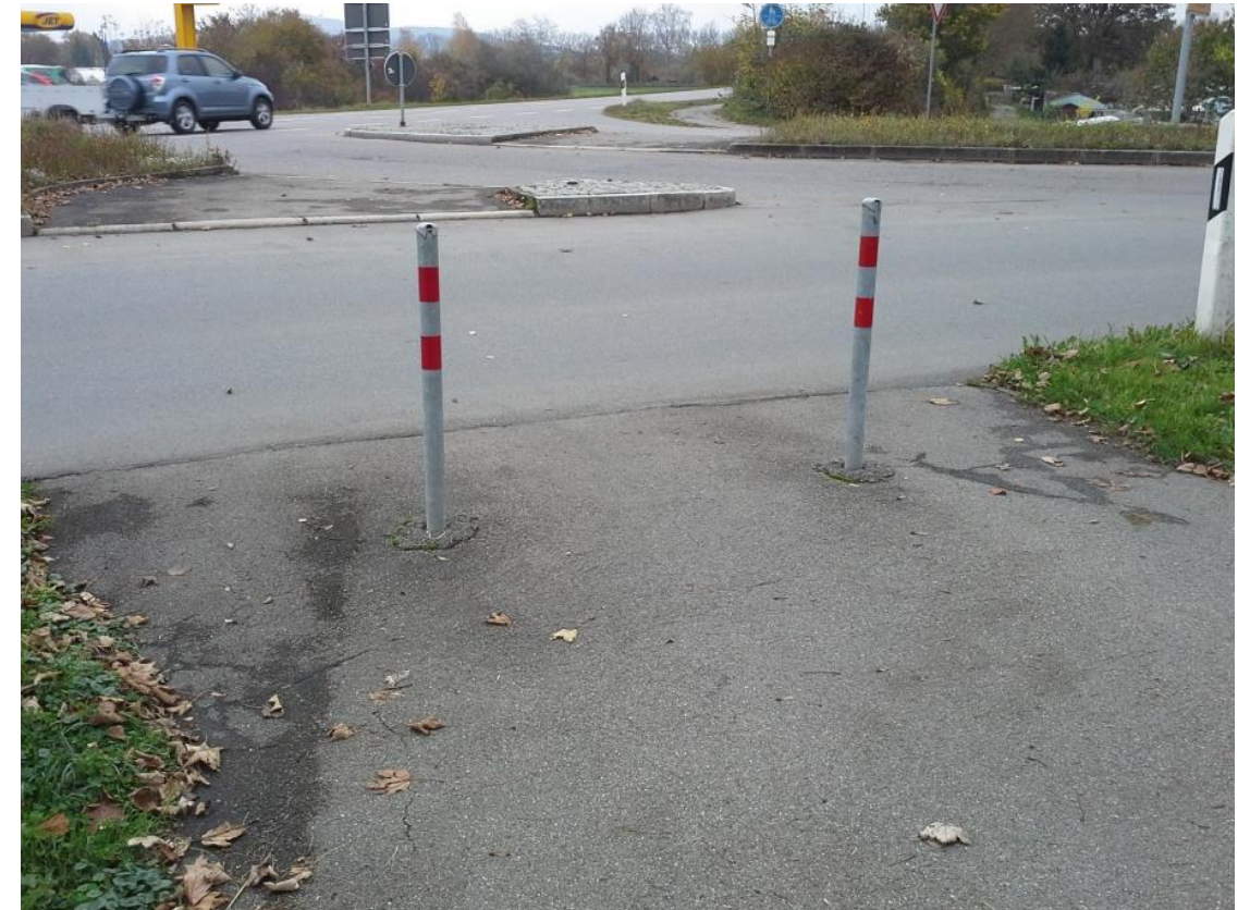
Barriere, Zwiefalter Straße
