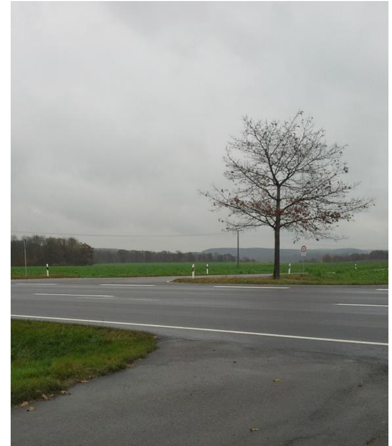
Beispiel für eine fehlende Querungshilfe B 312 - Zwiefaltendorf
